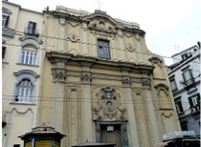
La facciata barocca delle Chiesa di Santa Maria di Caravaggio presso l'Istituto Denza di Napoli, dove si è concluso il pellegrinaggio.
